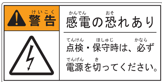
F 9 感電警告点検ラベル
